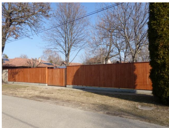
Zrínyi utca 25.(hrsz.: 1879) védett épület elbontva (2019.)
