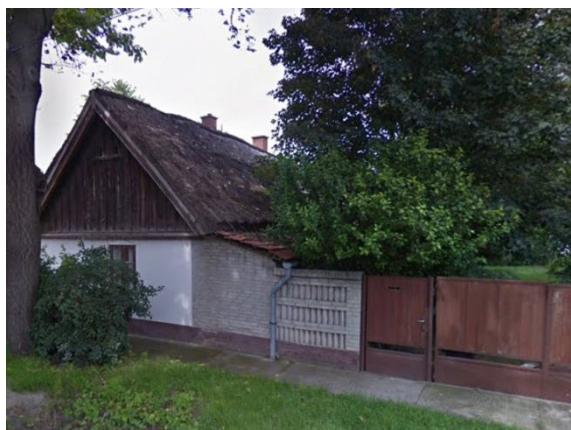
Zrínyi utca 25.(hrsz.: 1879) védett épület a Google Street Wiew felvételén
