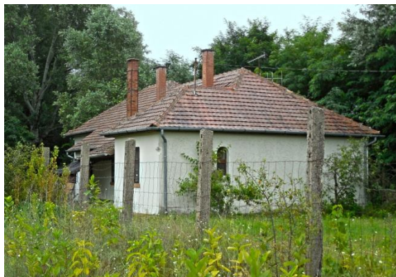
Külterület, Felsőszállás 29., Iskola (hrsz.: 0658/74)
