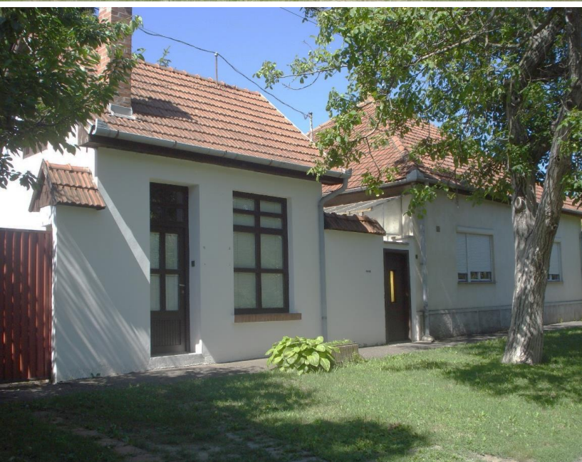
GYÖNYÖRŰEN ILLESZKEDIK A KIS ÜZLETÉPÜLET TÖMEGE ÉS HOMLOKZATI TAGOLÁSA A SZOMSZÉDOS SÁTORTETŐS HÁZHOZ, MIKÖZBEN ÖTTLETESEN VISSZAUTAL A MEZŐVÁROSI ÉRTÉKEKRE
