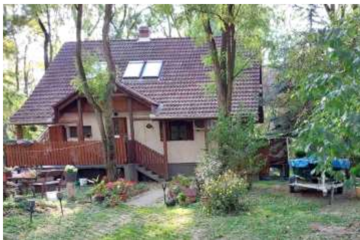
Meglévő épület a tervezési területen:
